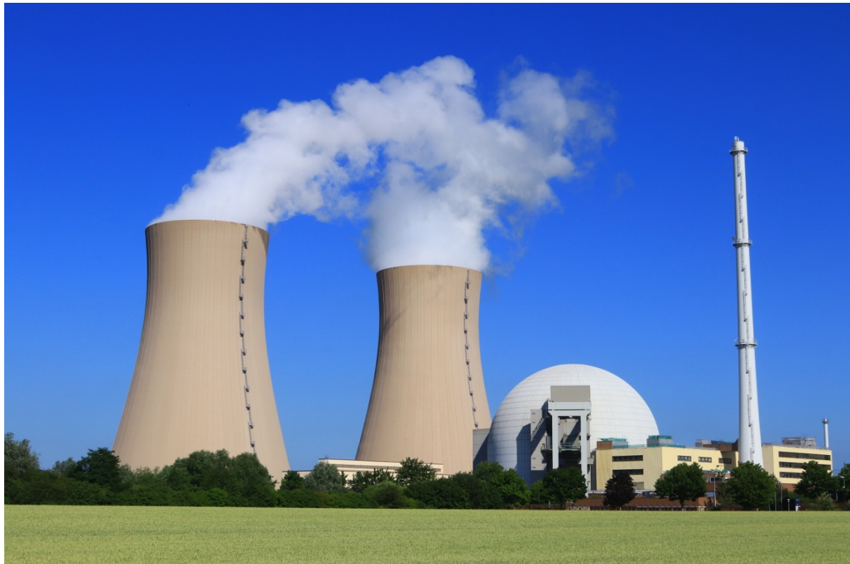
Beispiel für einen Druckwasserreaktor der Generation II: Kernkraftwerk Grohnde in Niedersachsen. Leistung 1.360 MW
